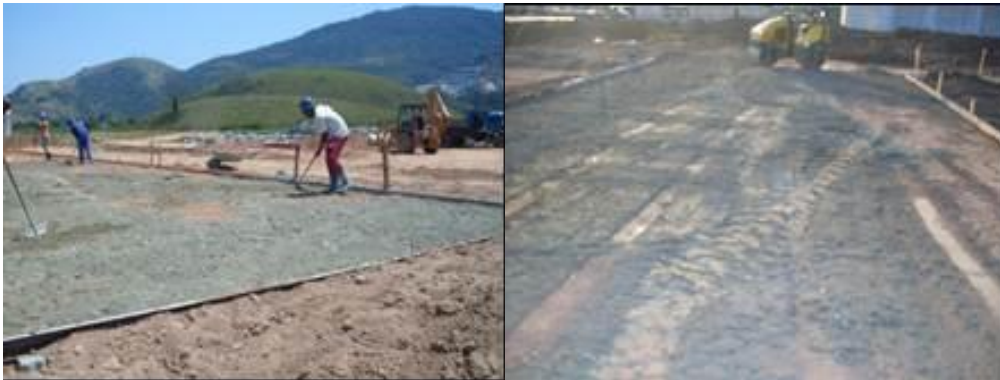
Distribuição da camada de bica corrida e nivelamento do piso.
