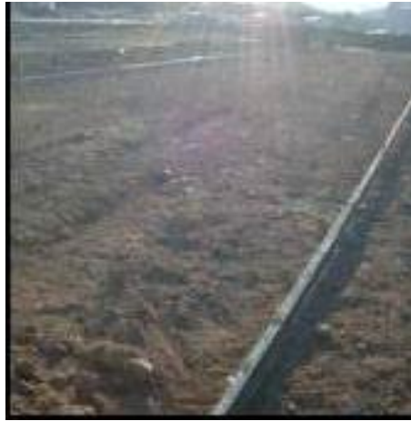
Colocação das fôrmas
